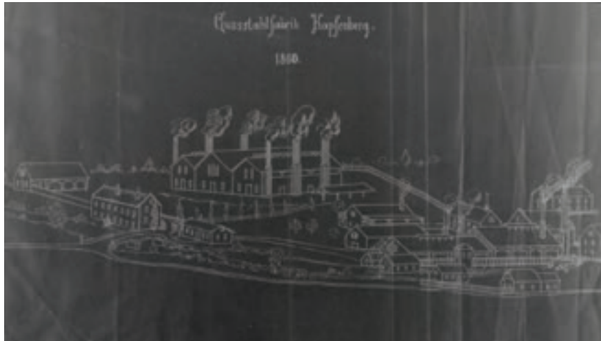
Handzeichnung der Gusstahlfabrik Kapfenberg aus dem Jahre 1860, damals in Besitz von Franz Mayr-Mellnhof. Nur 6 Jahre früher, also 1854, wurde hier zum ersten Mal Gusstahl erzeugt.
